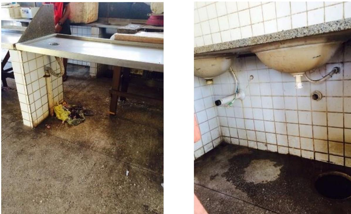
**Figura 6** - Estado de conservação das pias e esgoto. (Fonte: Edésio Silva)
